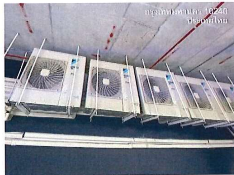
รูปที่ 27 คอมเพรสเซอร์เครื่องปรับอากาศของโครงการ
