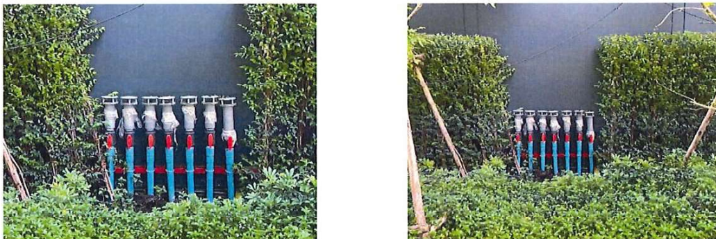
รูปที่ 34 บริเวณบ่อดิน บำบัดกลิ่น บำบัดละอองน้ำเสีย กำจัดก๊าซมีเทน ด้วยวิธี Soil Bed
