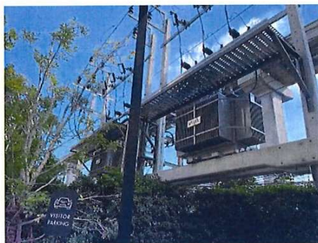
รูปที่ 23 หม้อแปลงไฟฟ้าของโครงการ
