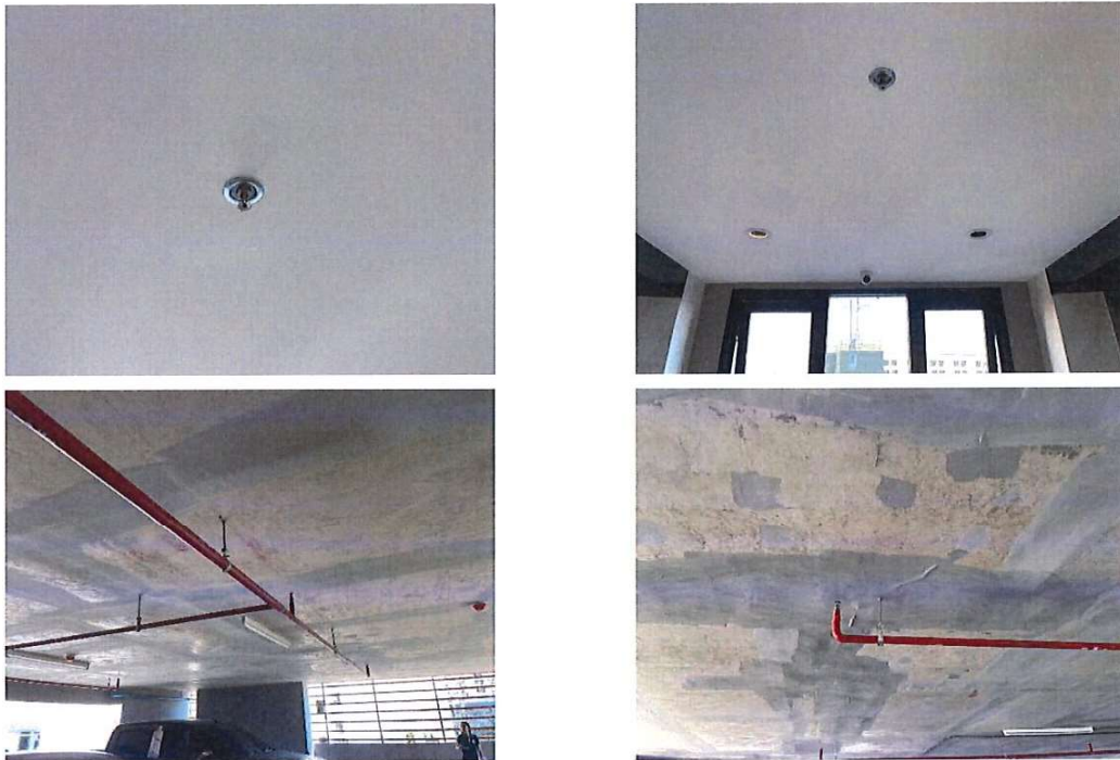
รูปที่ 54 ระบบดับเพลิงแบบกระจายน้ำอัตโนมัติ (Sprinkler System)
